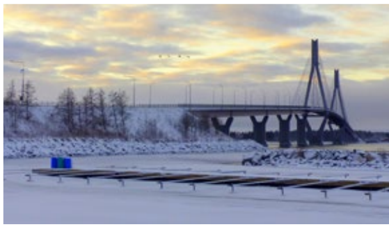
Matti Hietala, Vaasa. "Merenkurkku, Raippaluodon silta, joutsenia ja talventörröttäjiä, 17.1.2021, Mustasaari".
