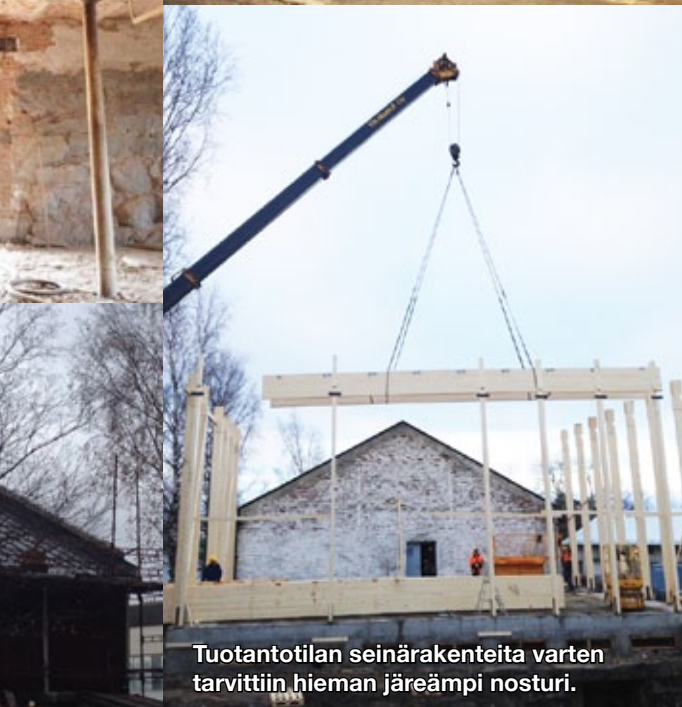
Kun seinärakenteet ovat paikoillaan voidaan aloittaa seinäelementtien asennus.
