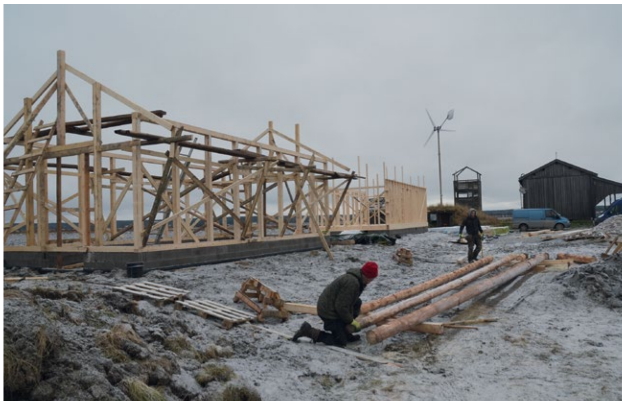
Uudet näyttelyladot rakennetaan talven aikana/ Nya utställningslador byggs under vintern. Fredrik och Christoffer Bäckström, Sundom byggtjänst, på Meteorians byggplats i slutet av november.
